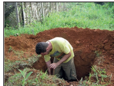
Realização dos testes de infiltração
